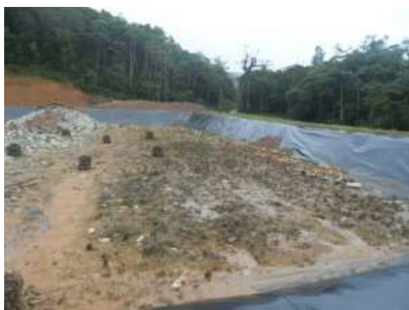
Aterro sanitário em fase de construção (2011)
